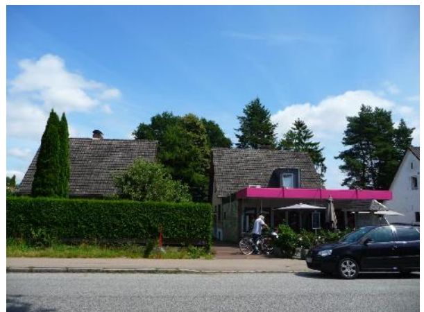
Abb. 5d Blick auf die Nachbarbebauung Kieler Straße Nr. 62 - 64
